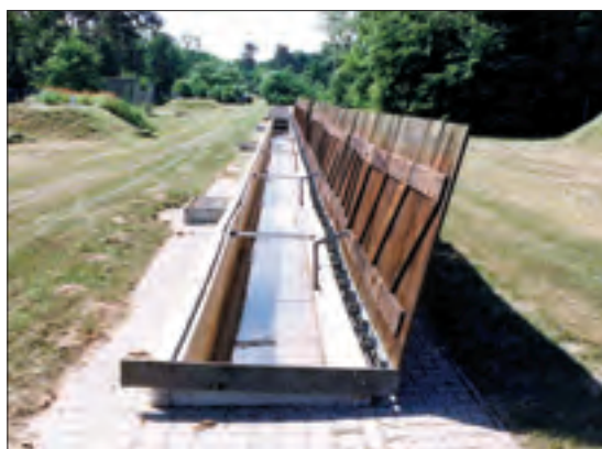
Sickerschlitzgraben und Einzelbohrungen zur Infiltration
