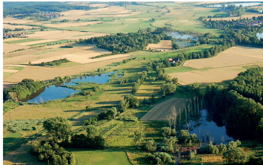
Links: Aufberei- tungsanlage des Wasserverbands Hessisches Ried in Biebesheim
